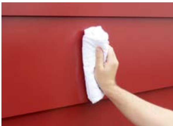
Abb. Reinigung von Platten
